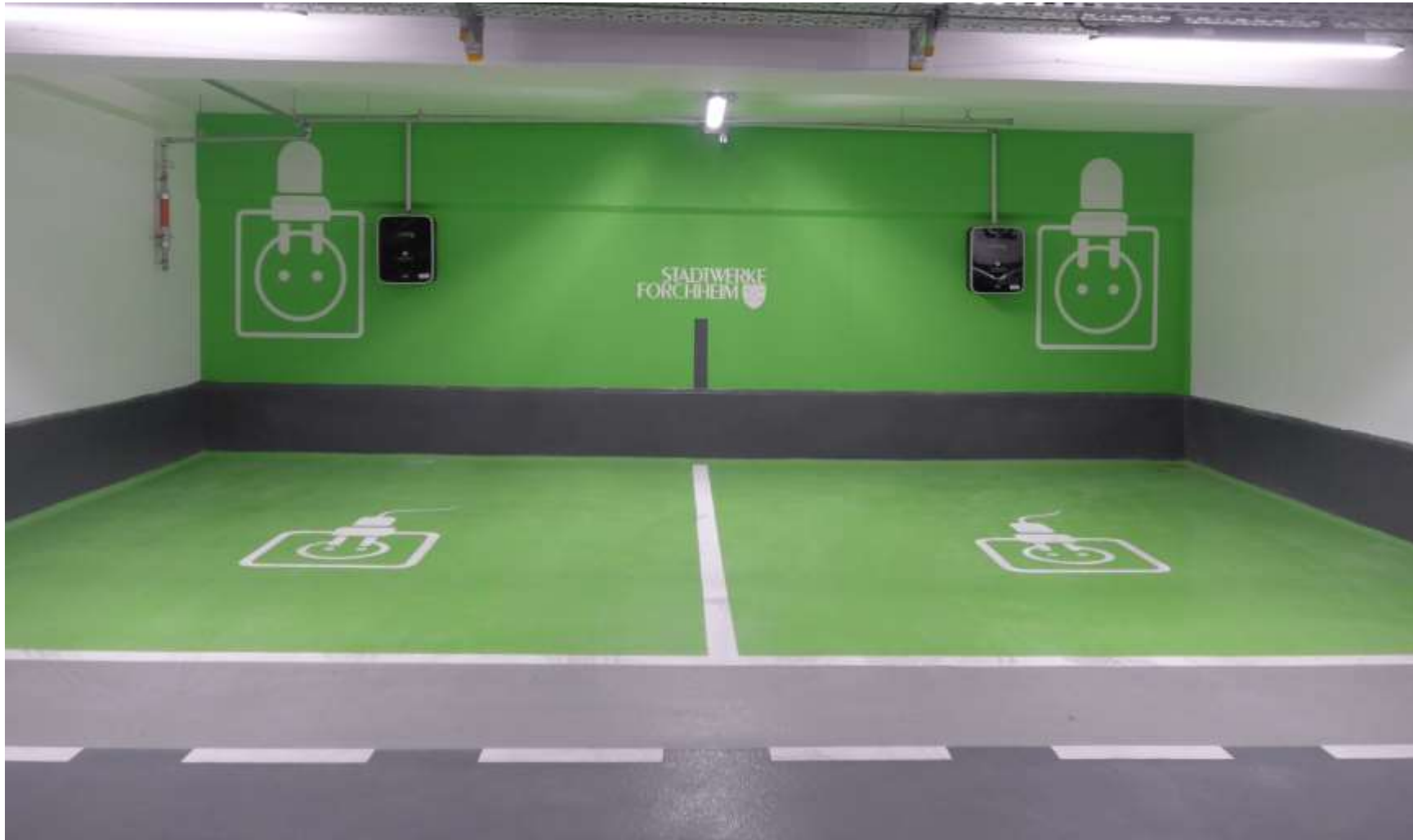
Ladestation für 2 Fahrzeuge in der Tiefgarage Forchheim
